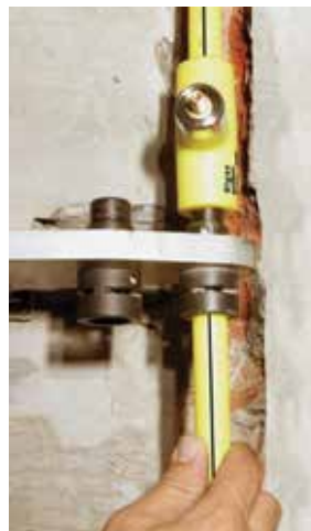
Termofusão do tubo
