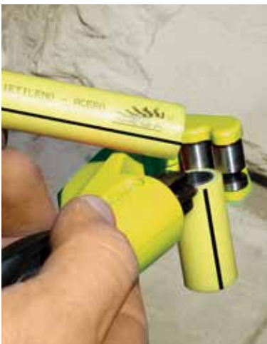
Corte com corta-tubos em obra.
